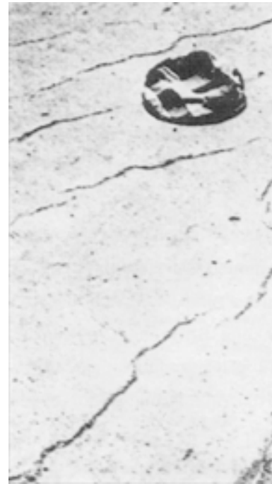
รูปที่ 17.5 รอยแตกร้าวที่เกิดจากการระเหยอย่างรวดเร็วของน้ำ
