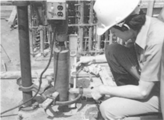
รูปที่ 19.3 งานเจาะคอนกรีตในโครงสร้างเพื่อทดสอบ
