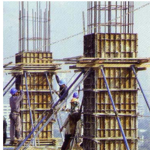
ค. แสดงการตั้งแบบเสาและกำหนดระดับท้องคานชั้นที่ 2
