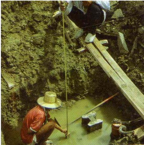
ก. แสดงการตรวจสอบระยะจากฐานราก
