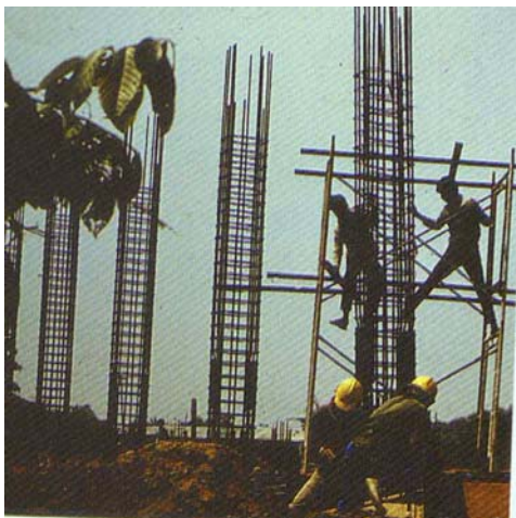
ค. แสดงการตั้งแบบเสาและกำหนดระดับท้องคานชั้นที่ 2
