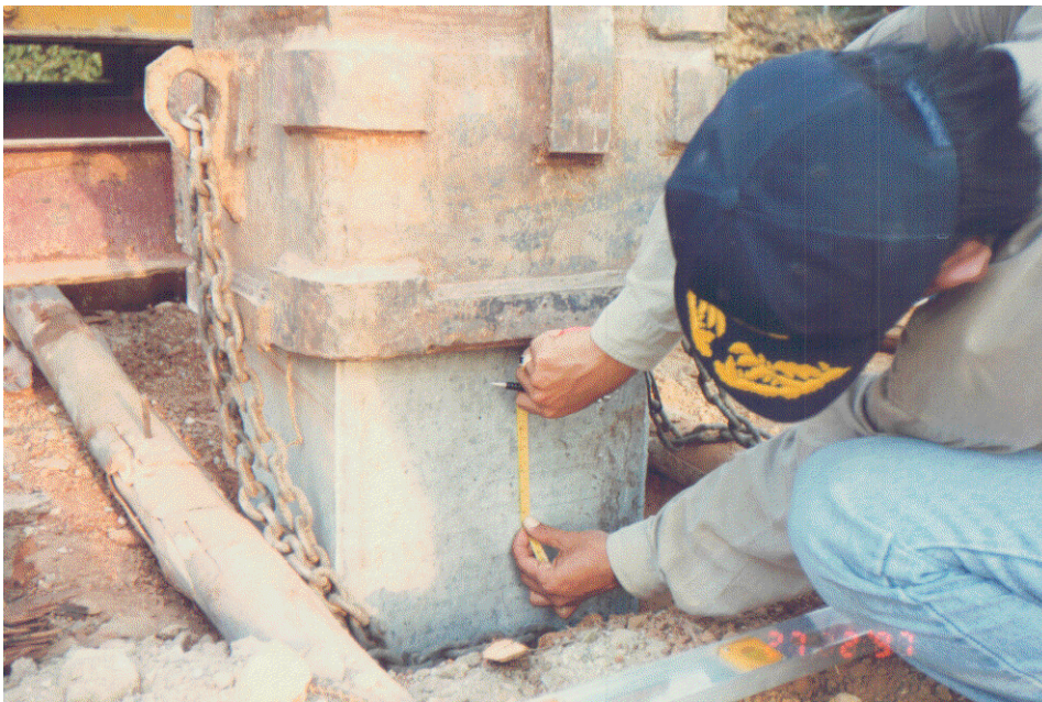
ภาพที่ 5 การตรวจสอบการทุรตุตตัวเฉลี่ยของเสาเข็ม เพื่อประเมินกำลังรับน้ำหนักบรรทุก โดยวิธี Dynamic Formula
