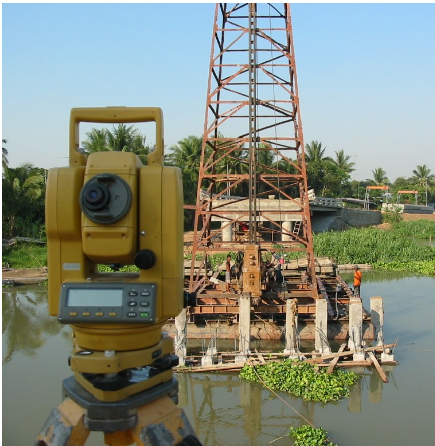
ภาพที่ 3 การตอกเสาเข็ม ต้องตรวจสอบแนวดิ่งของเสาเข็ม คุณภาพของเสาเข็ม
