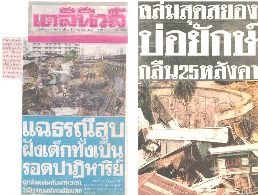
รูปที่ 1-10 ข่าวหน้าแรก การวิบัติของระบบกันดินสำหรับการก่อสร้างบ่อบำบัดน้ำเสียขนาดใหญ่ที่ฝังไว้ใต้ดิน เมื่อ 17 สิงหาคม 2540 (ข่าวจาก หนังสือพิมพ์เดลินิวส์)
