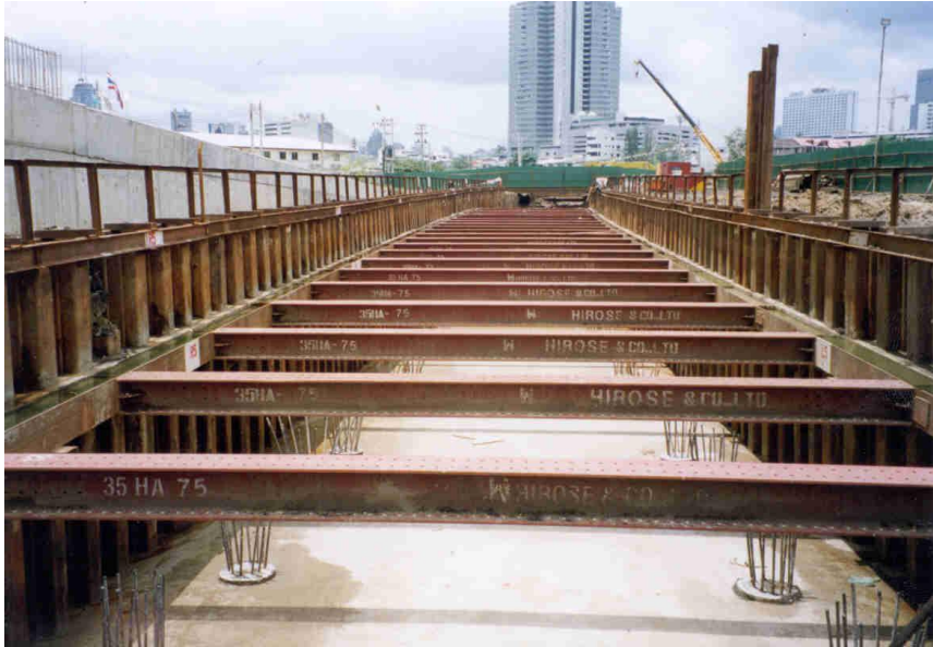
รูปที่ 1-8 กำแพงกันดินเข็มพืดเหล็กสำหรับก่อสร้างอุโมงค์รถไฟฟ้าใต้ดิน
