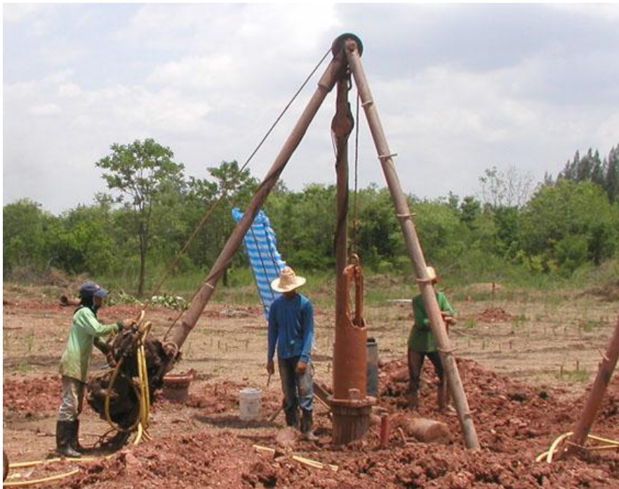
รูปที่ 4-16 เครื่องมือที่ใช้เจาะเสาเข็มเจาะแบบสามขา
