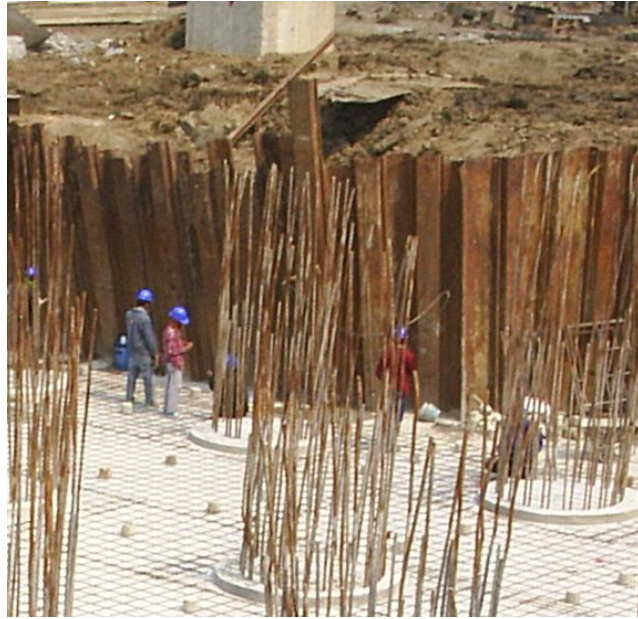
รูปที่ 5-61 เมื่อใช้ sheet pile เป็นกำแพงกันดินแบบ Cantilver การเคลื่อนตัวที่เกิดขึ้นจะสูงมาก
