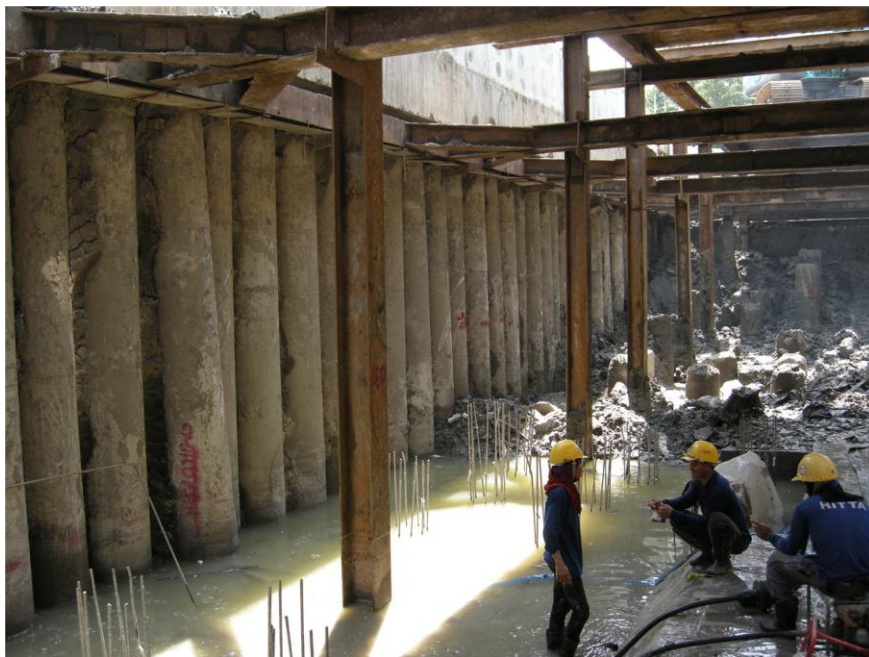
รูปที่ 1-9 กำแพงกันดินแบบเข็มเจาะเรียงต่อเนื่องเพื่อใช้ก่อสร้างอุโมงค์สำหรับรถยนต์
