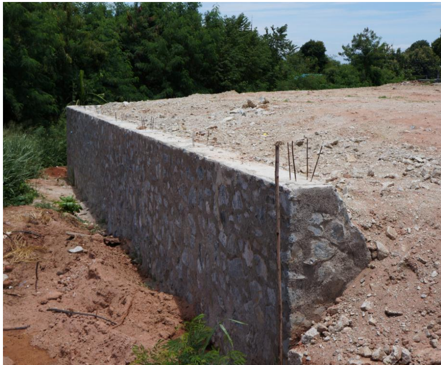
รูปที่ 5-7 กำแพงกันดิน gravity wall สำหรับกันดินกรณีถมดินชิดเขตที่ดิน
