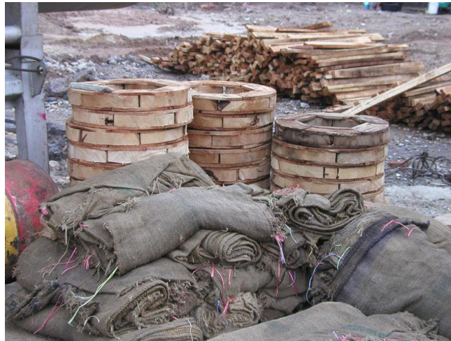
รูปที่ 4-62 ไม้หมอนรองเสาเข็ม และกระสอบรองเสาเข็ม
