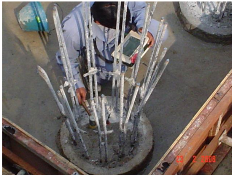
รูปที่ 4-68 การทำ Sonic integrity test
