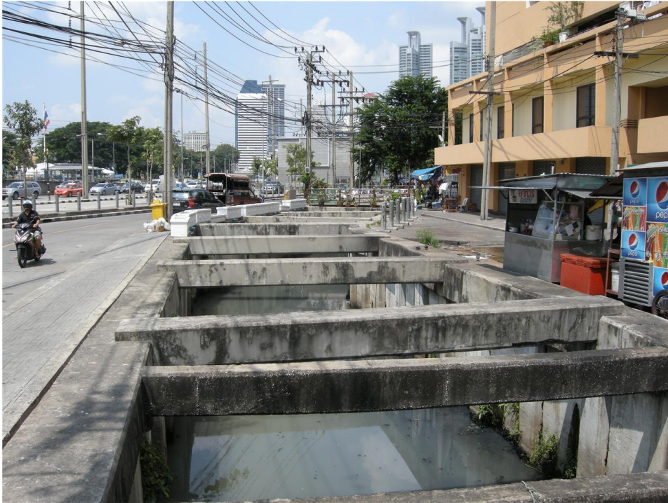
รูปที่ 5-50 กำแพงกันดินแบบฝังปลายที่มีค้ำยันด้านข้าง 1 ตำแหน่ง
