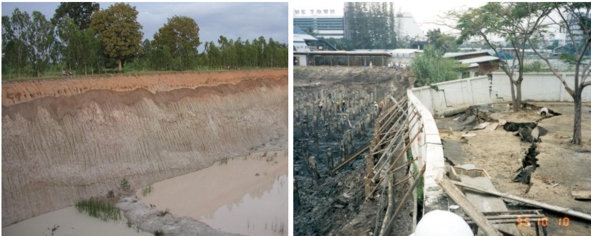
รูปที่ 5-1 การขุดเปิดหน้าดิน (a) ชั้นดินลูกรังขุดลึกประมาณ 20 เมตร: (b) ชั้นดินเหนียวอ่อนกรุงเทพขุดลึกประมาณ 3 เมตร
