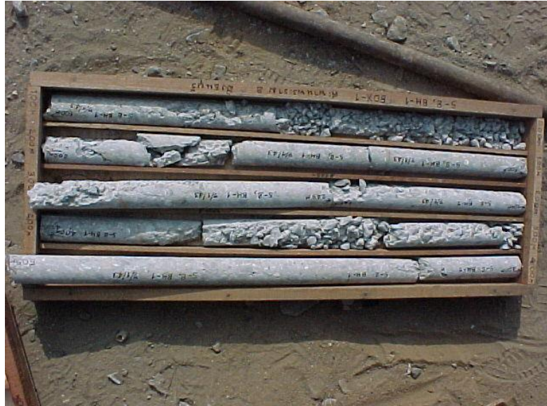
รูปที่ 4-70 แท่งคอนกรีตในเสาเข็มที่ถูกเจาะขึ้นมาพบว่าคอนกรีตแยกตัวจากหิน
