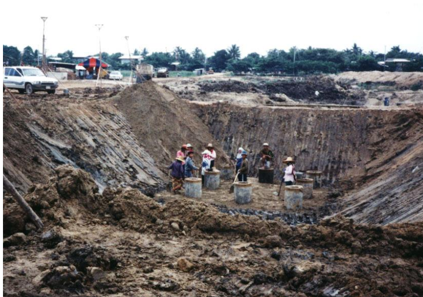
รูปที่ 1-5 การขุดเปิดหน้าดินเพื่อก่อสร้างฐานรากของโครงสร้างทางด่วน
