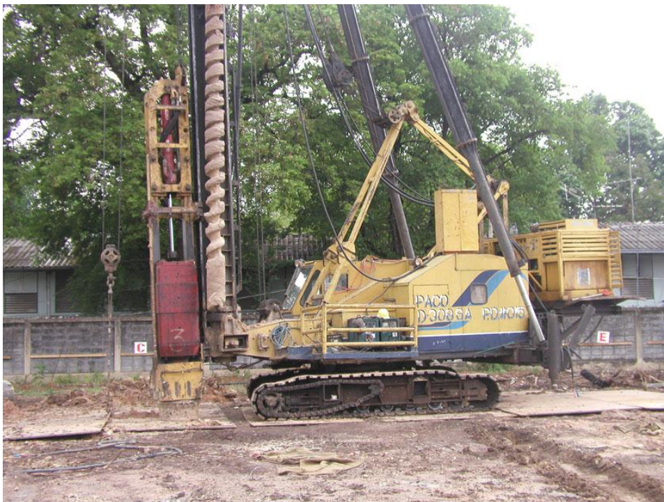
รูปที่ 4-15 เครื่องจักรตอกเสาเข็มแบบติดตั้งบนรถเครนซึ่งมีเครื่องจักรสำหรับเคลื่อนย้ายตัวเองได้
