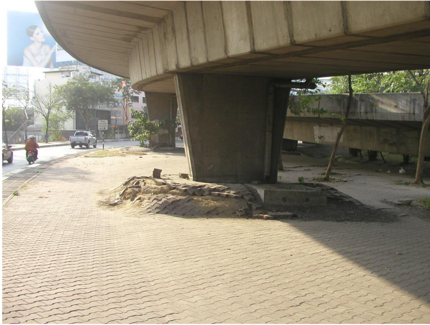
รูปที่ 1-12 การทรุดตัวที่ต่างกันระหว่างชั้นดินถมกับฐานรากของสะพานที่วางอยู่บนเสาเข็ม
