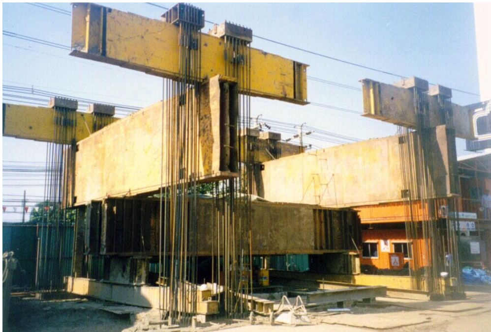
รูปที่ 4-74 การทดสอบเสาเข็ม
