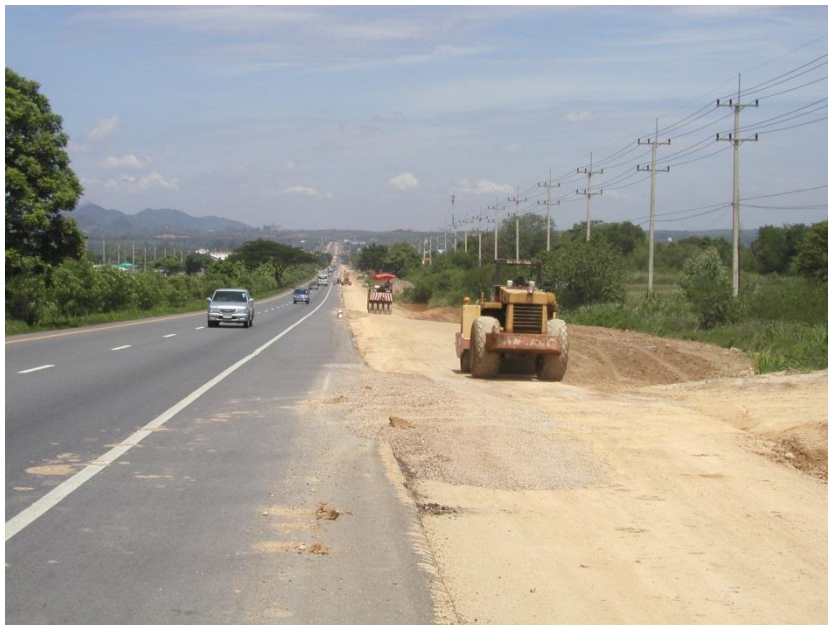
รูปที่ 1-3 งานขยายถนนทางหลวงหมายเลข 2 สายสระบุรี – นครราชสีมา ซึ่งใช้ดินเป็นวัสดุก่อสร้าง
