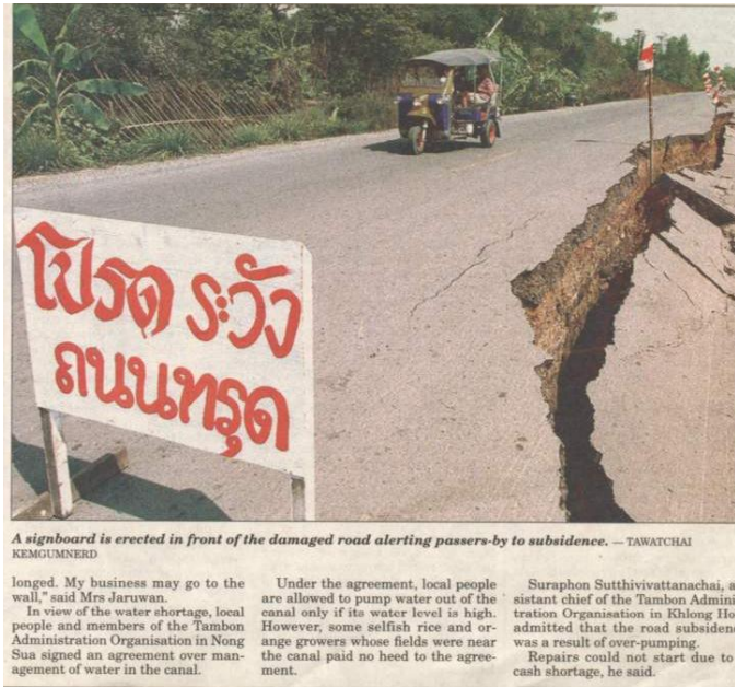
รูปที่ 1-11 ขบวนการวิบัติของถนนสายรังสิต-นครนายก
