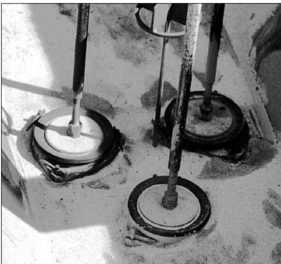
รูปที่ 9 วาล์วเปิด-ปิดในแต่ละ Station
