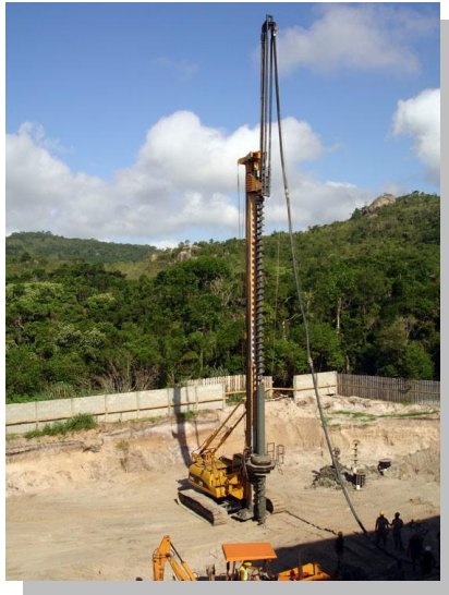
รูปที่ 10.5 แสดง Continuous-flight auger boring 6
