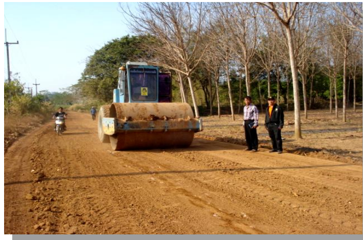
รูปที่ 1.29 แสดงในปัจจุบันใช้รถบดดินทำให้ถนนแน่นขึ้น 35
