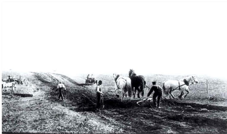
รูปที่ 1.27 แสดงถึงการทำถนนด้วยแรงงานม้าโดยไม่มีกรบอัด 33
