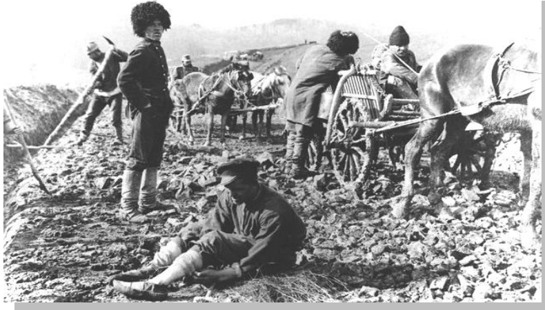
รูปที่ 1.26 แสดงถึงการใช้หินปูพื้นถนนแล้วใช้ดินกลบผิวหน้าของถนนให้เรียบ 32
