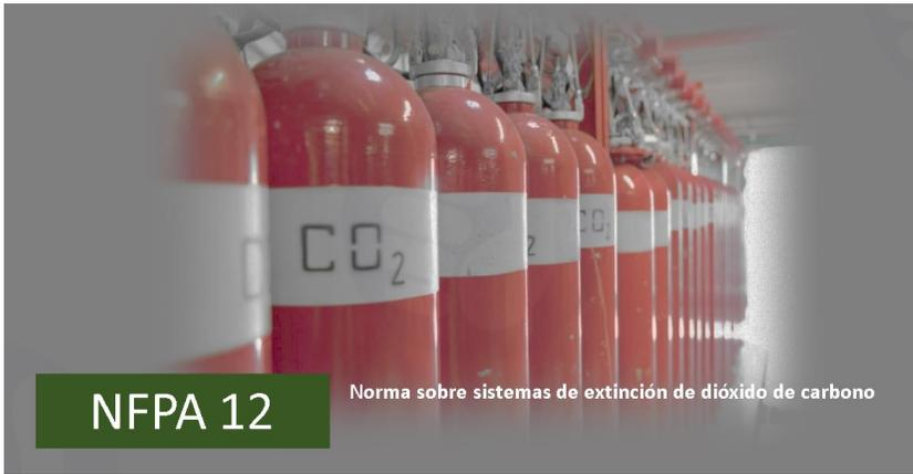
El dióxido de carbono Al tratarse de un gas no combustible y que no presenta reacciones químicas con otras sustancias, y al ser un gas que puede comprimirse, es posible introducirlo dentro de un extintor sin necesidad de agregar otros productos para poder descargarlo. Su eficacia se basa en su capacidad para desplazar rápidamente el oxígeno, consiguiendo así extinguir el fuego.
