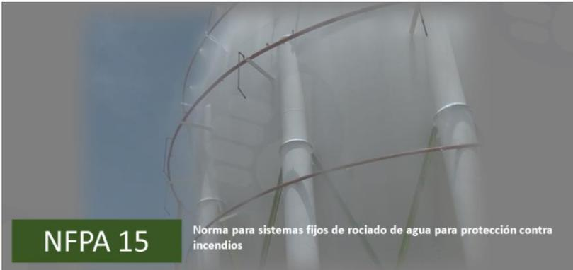
Los sistemas de rociado de agua están diseñados para proteger varios tipos de riesgos, que pueden incluir líquidos inflamables y combustibles. Estos sistemas pueden estar diseñados para funcionar de forma automática o manual.
