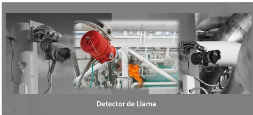
Los detectores de llama se activan en respuesta a la energía radiante generada por la llama o la combustión.
