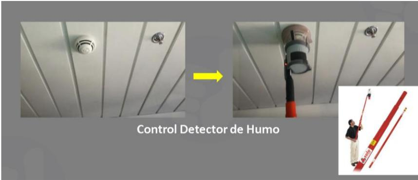
**El comprobador de detectores térmicos** más conocido en el sector, es un comprobador de detectores térmico a batería que se conecta a un tubo de acceso Solo que permite un alcance máximo de 9 metros. Con su tecnología dirige un haz de calor orientado directamente al sensor.
