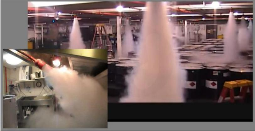
Debido a que el dióxido de carbono se descarga en forma gaseosa por la presión interna de almacenamiento y los vapores son más pesados que el aire, los sistemas de extinción de dióxido de carbono generalmente se encuentran en ubicaciones interiores, protegiendo los siguientes peligros:
