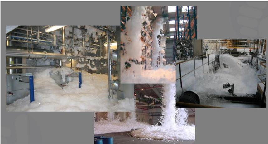
Las espumas se pueden aplicar a incendios a través de sistemas fijos. El equipo fijo de extinción de espuma puede ser automático, manual o una combinación de ambos. Algunos sistemas consisten en uno o más extintores de espuma portátiles
