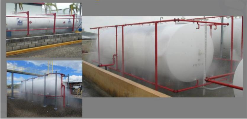
El término agua pulverizada se refiere al agua que es descargada desde boquillas o dispositivos especialmente diseñados para producir un patrón predeterminado, tamaño de partícula, velocidad y densidad. Los sistemas de pulverización de agua han sido provistos para proteger un equipo específico cubriendo su superficie con las gotas de la descarga.
