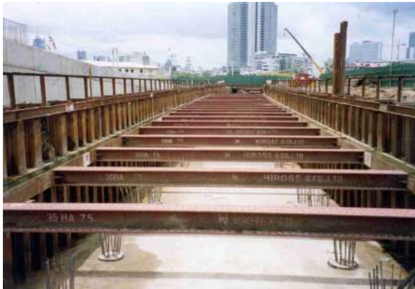
รูปที่ 1-9 กำแพงกันดินเข็มพืดเหล็กสำหรับก่อสร้างอุโมงค์รถไฟใต้ดิน
