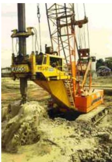
รูปที่ 2-23 เบนโทไนท์ที่ใช้เพื่อป้องกันหลุมเจาะพังทลายในงานเสาเข็มเจาะ
