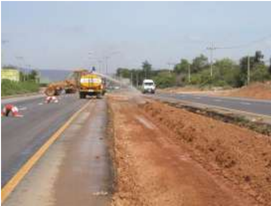
ฉีดน้ำตามปริมาณน้ำเหมาะสมที่ได้จากห้องปฏิบัติการ
