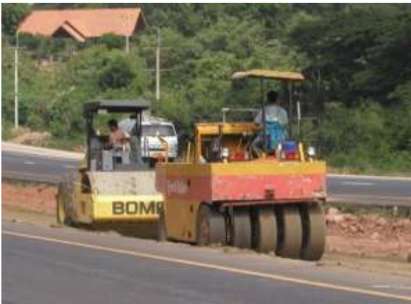
บดอัดดินที่คลุกกับน้ำให้แน่น
