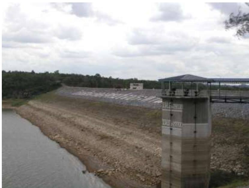
รูปที่ 1-5 เขื่อนลำตะคองเป็นเขื่อนของกรมชลประทาน ใช้ดินเป็นวัสดุสร้างตัวเขื่อน
