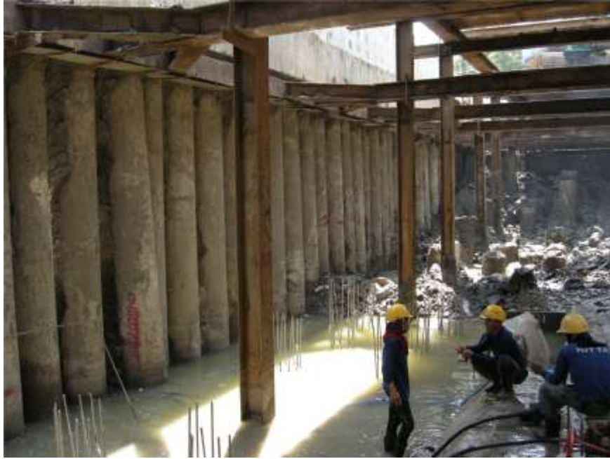
รูปที่ 1-10 กำแพงกันดินแบบเข็มเจาะเรียงต่อเนื่องเพื่อใช้ก่อสร้างอุโมงค์สำหรับรถยนต์
