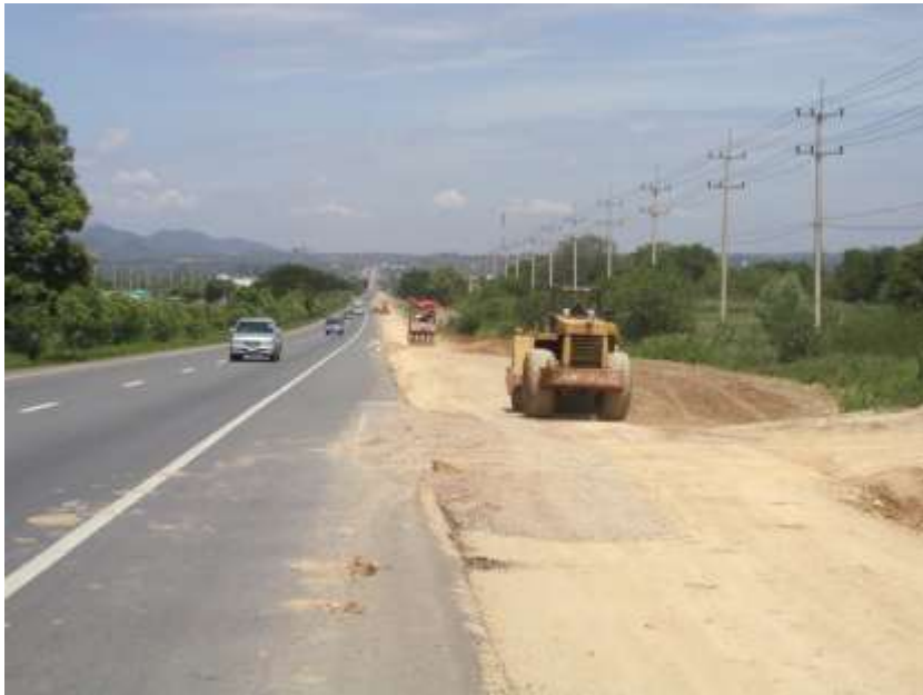
รูปที่ 1-4 งานขยายถนนทางหลวงหมายเลข 2 สายสระบุรี – นครราชสีมา ซึ่งใช้ดินเป็นวัสดุก่อสร้าง
