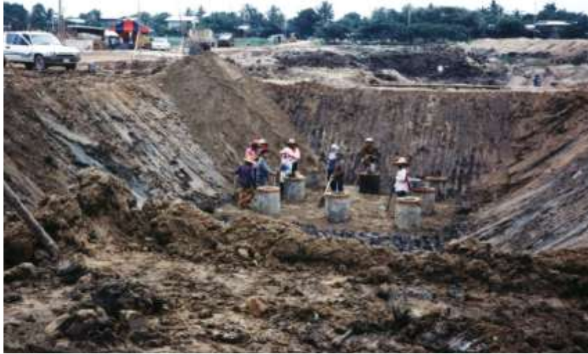
รูปที่ 1-7 การขุดเปิดหน้าดินเพื่อก่อสร้างฐานรากของโครงสร้างทางด่วน
