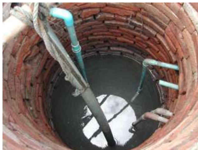
รูปที่ 5-13 บ่อน้ำในชั้นดินทรายเป็นชั้นน้ำแบบ unconfined aquifer
